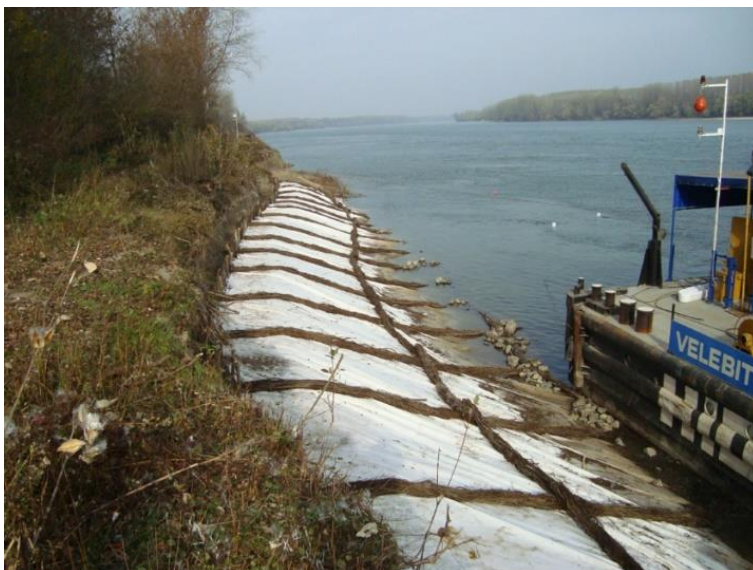
3. ábra: Geotextília és rőzsekolbászok alkalmazása Horvátországban (forrás: AVP).
