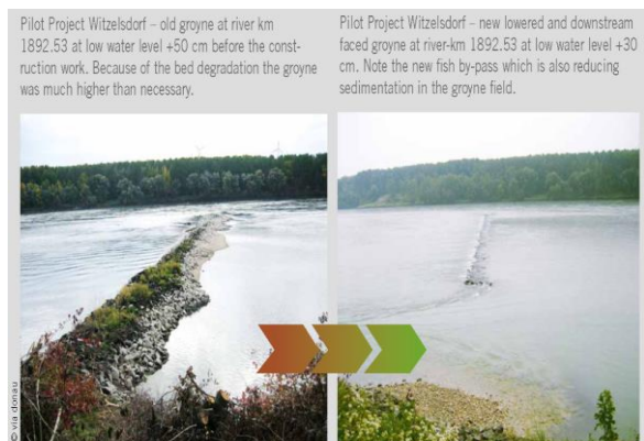
4. ábra: Sarkantyúk kiosztásának és irányának megváltoztatása a tervben (bal) és egy meglévő sarkantyú koronaszint csökkentése és part közeli átvágása (osztrák példa a Bécs alatti Duna szakaszról)
