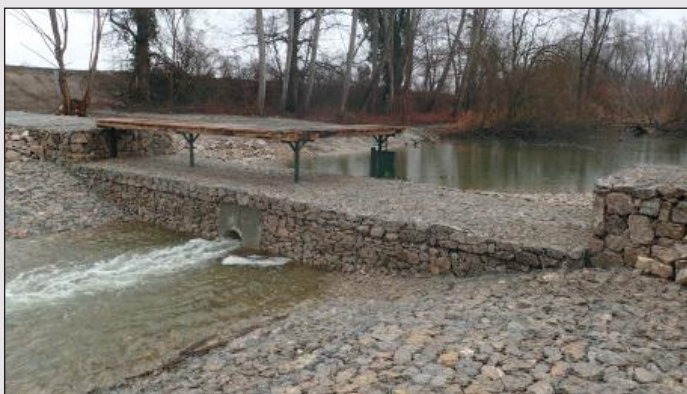
5.2.1 ábra: Az Ó-Dráva vízszintemelő fenékküszöbe alacsony vízállásnál. Fotó: Gruber Tamás
